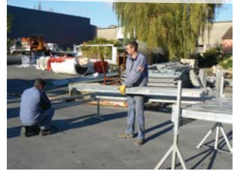
Montage de passerelles lors d'un exercice à Charleville-Mézières
