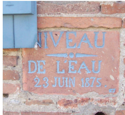
REPÈRE DE CRUE MATÉRIALISÉ SOUS LA FORME D'UNE GRAVURE À ONDES (COMMUNE BORDANT LA GARONNE)
